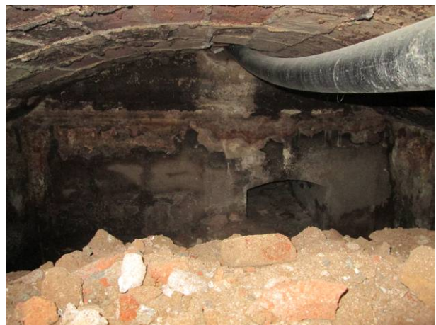
6. Interior de la fossa sèptica on s'observa la claveguera UE 5.
