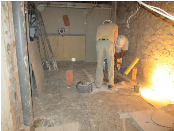
3. Inici dels treballs d'obertura del fossat.
